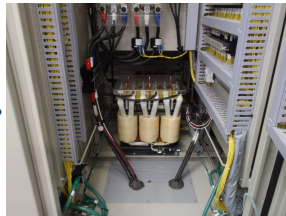
（スイッチ誤作動により焼損した電動機始動器の更新）
