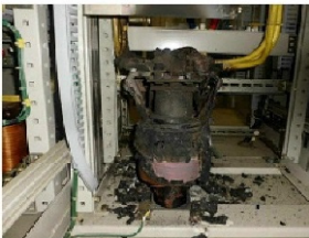
(スイッチ誤作動により焼損した電動機始動器の更新)
